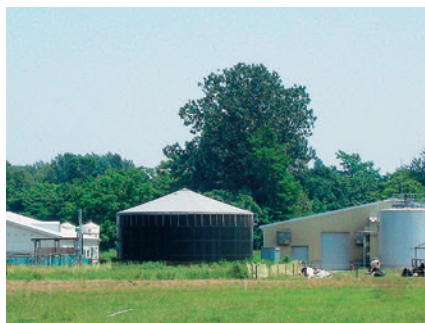
バイオガスプラント
