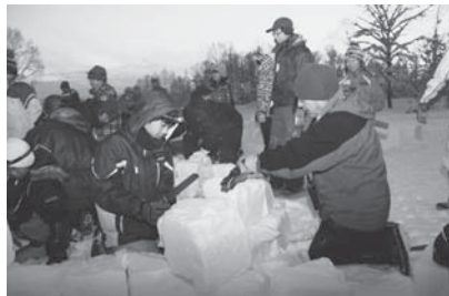
雪のブロックをのこぎりで整形しながら積み上げてイグルー作り。気温が氷点下30度近くまで低下したため、残念ながら途中で退散。
