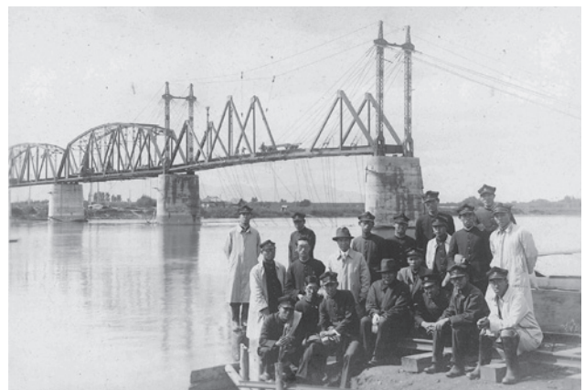
石狩川橋梁（札沼線）の架橋工事見学
