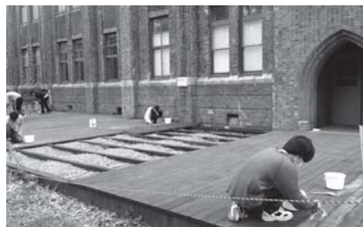
改修作業の様子
