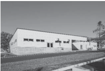
新七飯淡水実験所の外観
