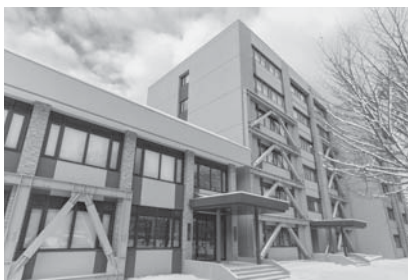
改修後の外観（東側）
