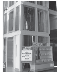
水産学部厚生会館の後付エレベーター
