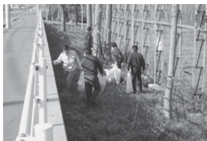
協力し合いながらの清掃作業
