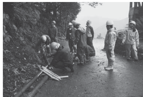
林道整備作業
