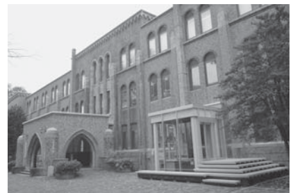
正面玄関横にバリアフリー玄関を設置
