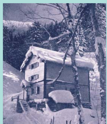
旧冷水小屋(スキー北海道、札幌鉄道局、1938より)
