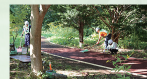
ウッドチップ敷き詰め作業の様子
