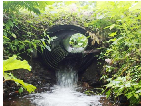
落差のある暗渠
