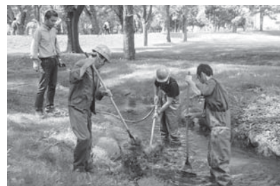
水底底部のエア吹きつけ
