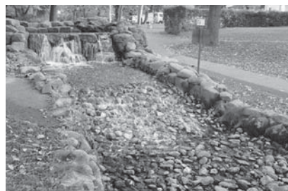
完成後の通水状況
