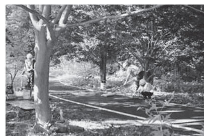
ウッドチップ舗装工事
