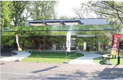
(写真: コンビニエンスストア外観)
