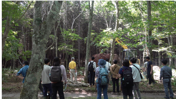
重機を用いてミズナラ成木（高さ15m）を根から掘り出している様子
